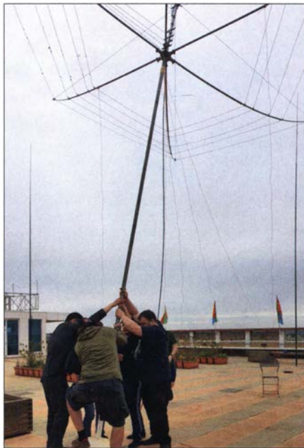
Teamarbeit beim Antennenaufbau
