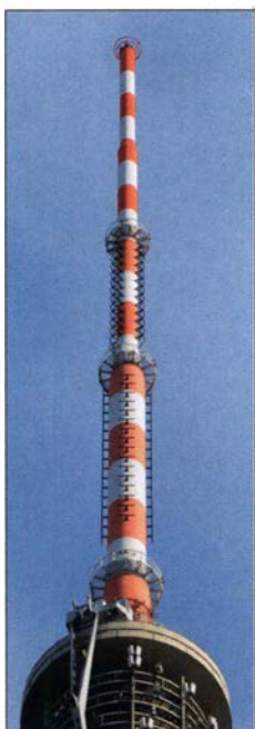
Antennenträger am 4. Mai 2013
