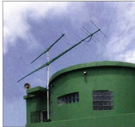
Die 2-m- und die 70-cm-Antennen von D4VHF am Standort des Monteverde-Contestteams in HK76MU. Statt auf 144,174 MHz wird D4VHF in der Sporadic-E-Saison wegen des hohen QRM-Levels stets auf 144,180 MHz arbeiten. Foto: D4C
