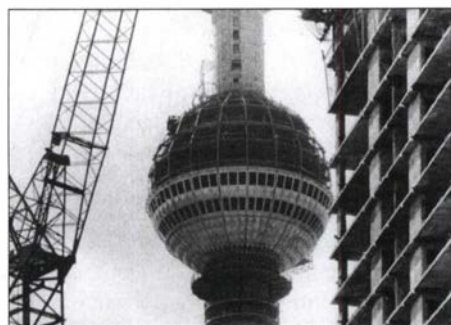
Baufortschritt am 22. August 1968
